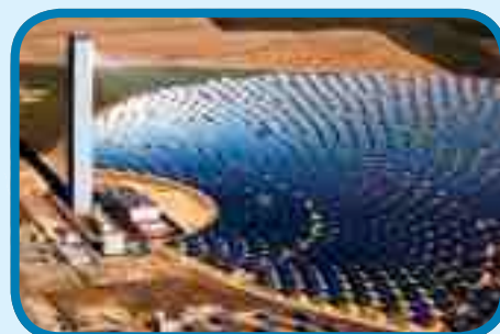
Solanlæg i Spanien producerer elektricitet til 10.000 indbyggere.
