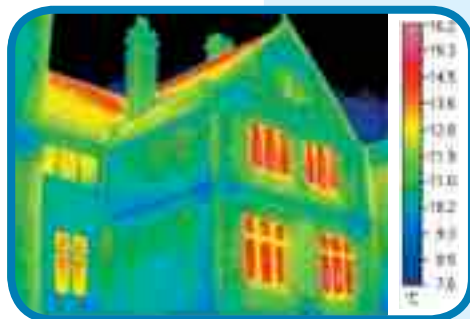
Med en speciel fototeknik kan man se, om huse er isoleret godt, eller om varmen blot slipper ud. Jo mere rødt, jo større varmetab.
